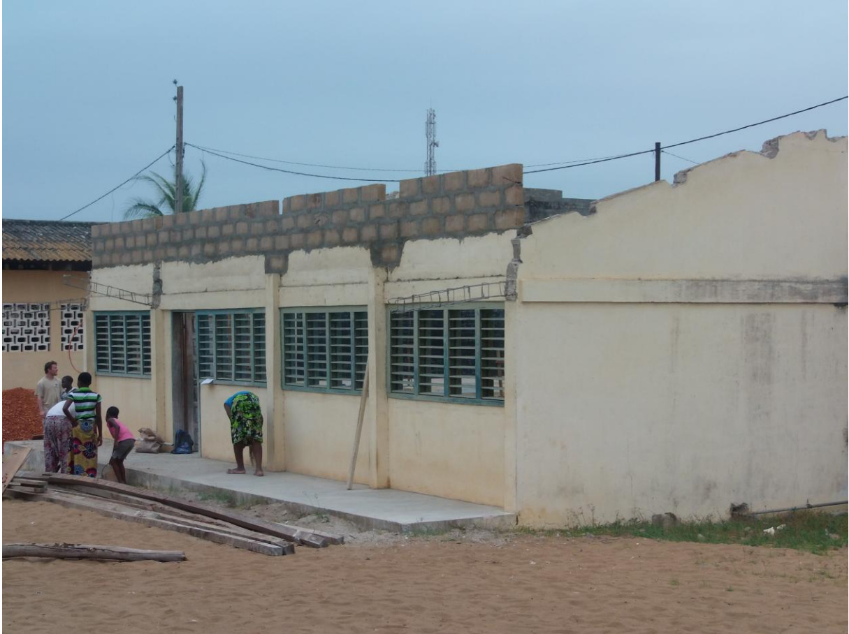
Montage des murs du Bâtiment
