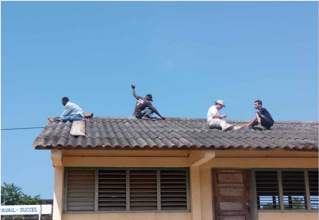
Démontage du toit
