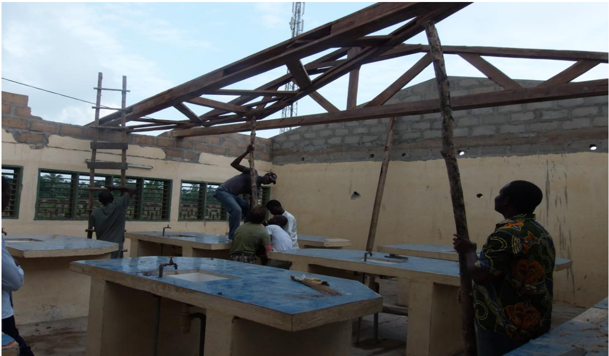
Montage de la charpente
