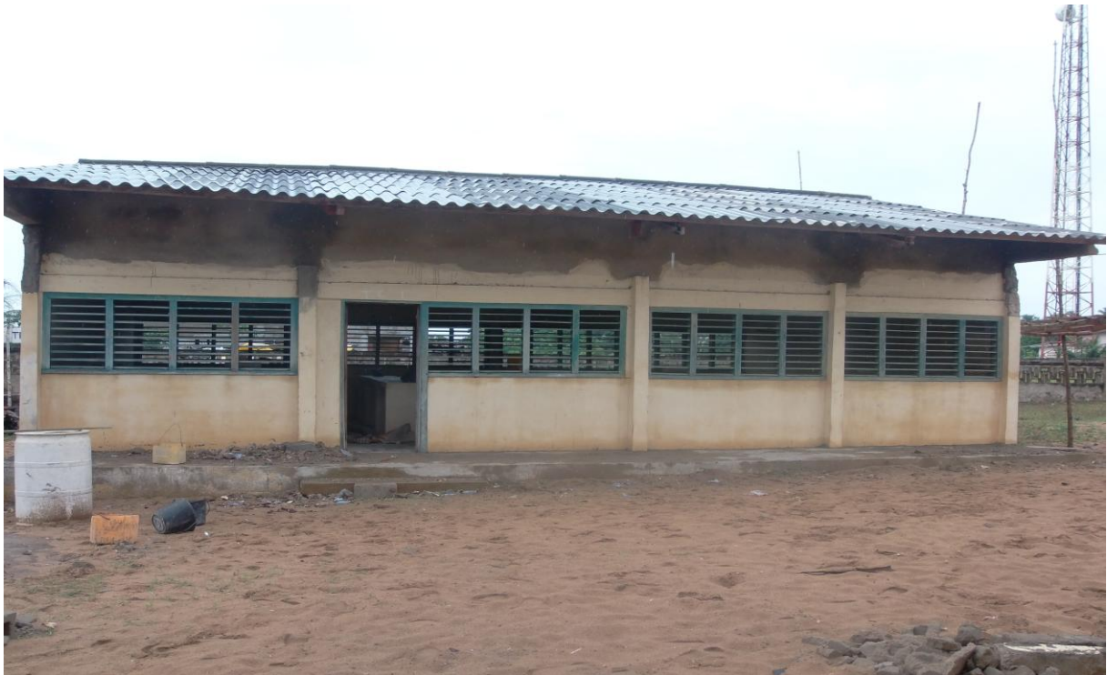
Crépissage et montage des tuiles par les charpentiers
