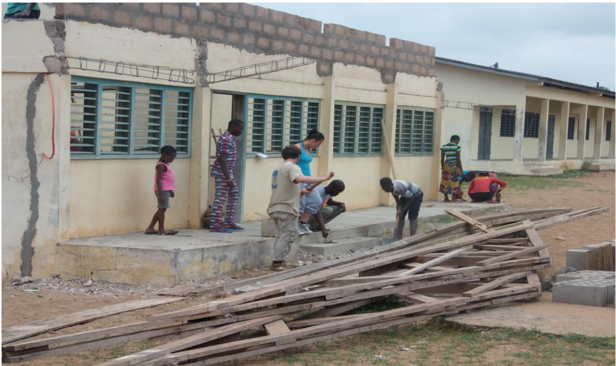
Démontage de la charpente
